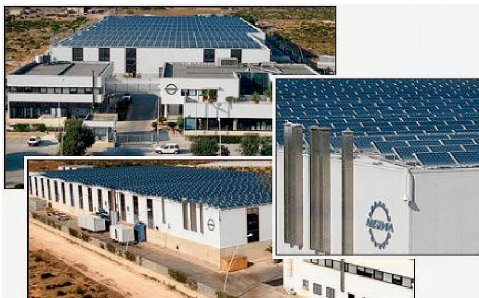
Figura 3. I 1.600 moduli al silicio sulla copertura di 7.000 m<sup>2</sup> del capannone della marsalese Ausonia garantiscono una potenza di picco di 359 kW e una produzione annua d'energia elettrica di 550.000 kWh: 300.000 kWh servono a soddisfare il fabbisogno industriale e 250.000 kWh vengono ceduti alla rete elettrica nazionale.
