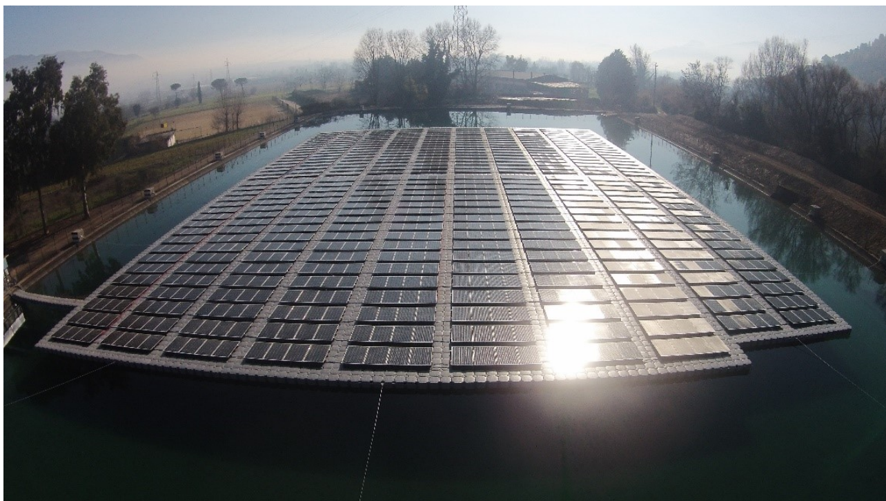
Figura 4. Impianto fotovoltaico galleggiante su un bacino del Consorzio di bonifica “Valle del Liri” nel comprensorio di Cassino.
